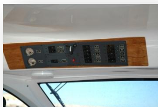
El puesto del piloto ofrece espacio suficiente para los elementos de control de motor y electrónica de navegación y comunicaciones.
